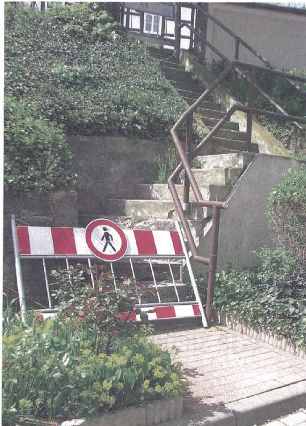
Kurze Gedankenspiele, die Treppe von der Schlossstraße hin zur Hämelschenburger Straße abzureißen, wurden schnell verworfen. Nun soll sie ebenso wie die dort befindliche Rampe saniert werden. tis
