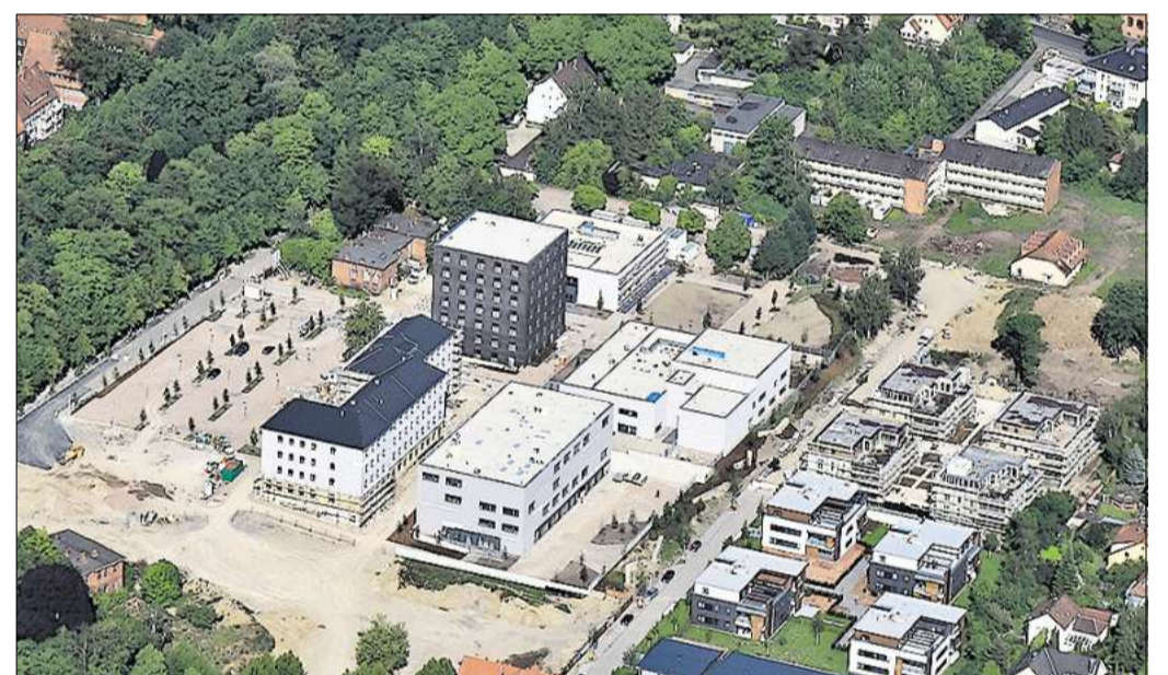
Das Areal am Weinberg in der Bauphase (links). Rechts neben dem Campus entstand das neue Wohngebiet, dessen Einheiten sich bestens vermarkten ließen.
